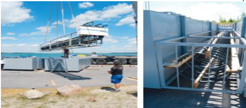
Pemasangan penukar haba dalam ponton untuk penyejukan dan pemanasan rumah terapung.
