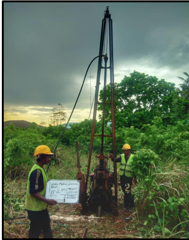
Gambar 1: Penggerudian telaga tiub menggunakan mesin gerudi YWE D45R.
