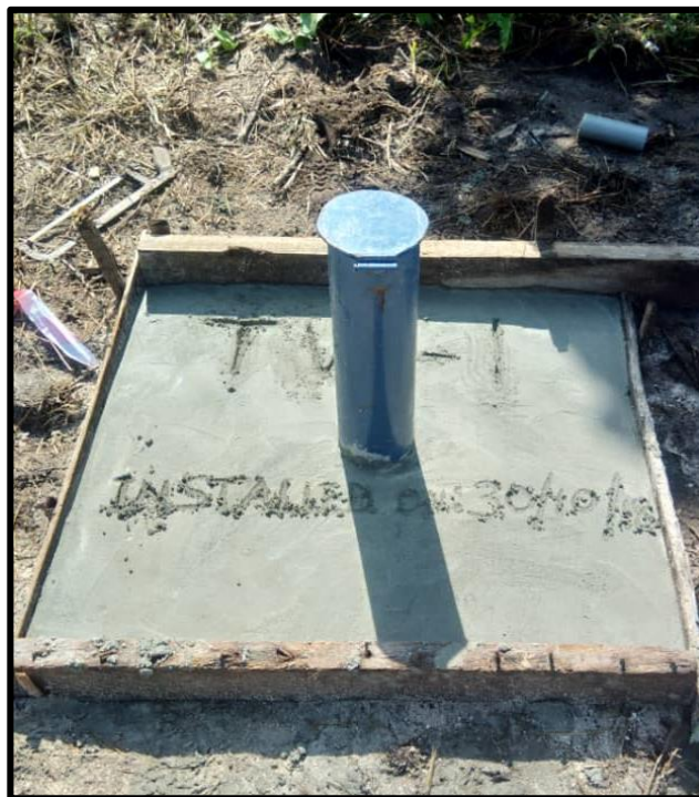
Gambar 4: Telaga yang telah siap ditutup dengan penutup besi.
