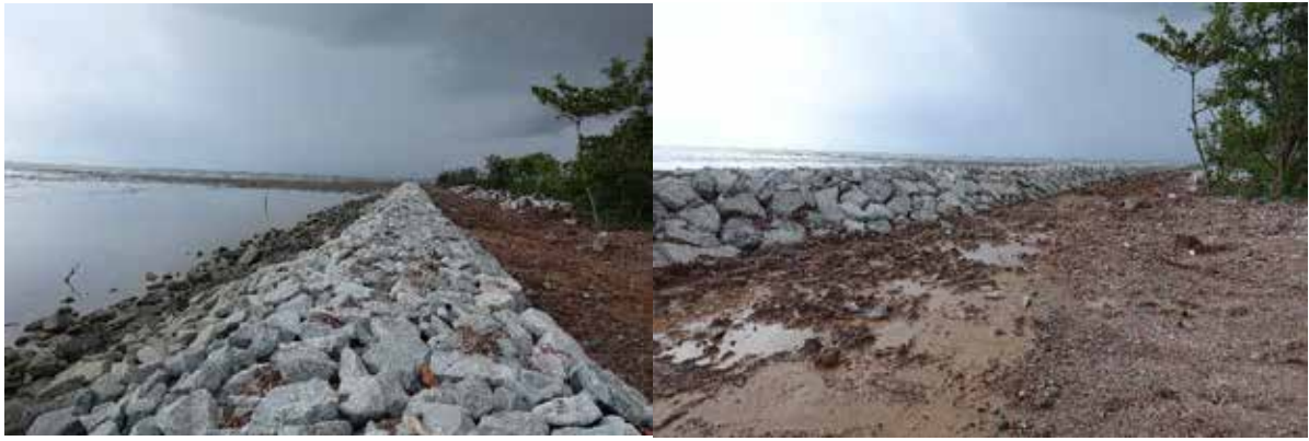
Foto 10: Pembinaan Ban Pantai Sepanjang Pantai Utara dari Kuala Kedah.
