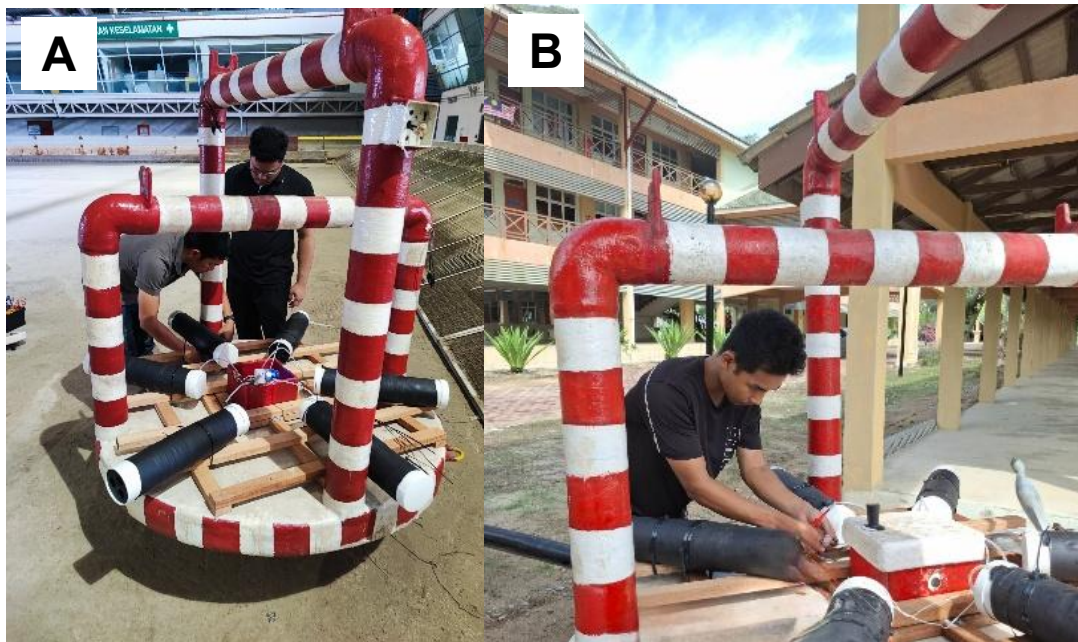
Gambarajah 3: Pemasangan komponen-komponen elektrik.
