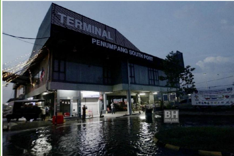
Limpahan air laut di sekitar Terminal Penumpang South Port, Pelabuhan Klang sekitar jam 6.42 pagi tadi. - NSTP/FAIZ ANUAR
