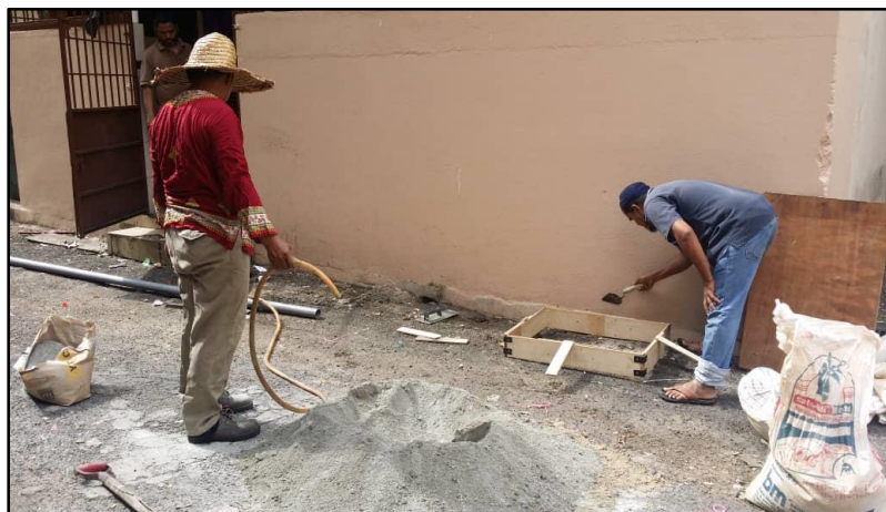
Rajah 12: Proses penyediaan tapak bagi meletakkan NoFAT Versi 2
