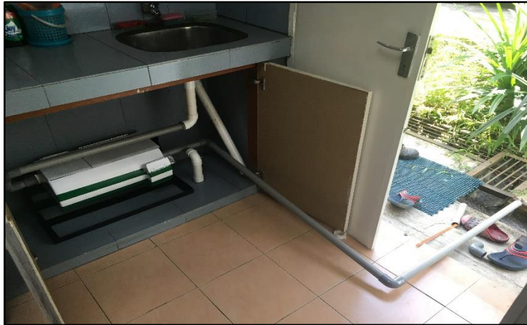
Rajah 18: Paip tambahan digunakan bagi tujuan mengambil sampel air
