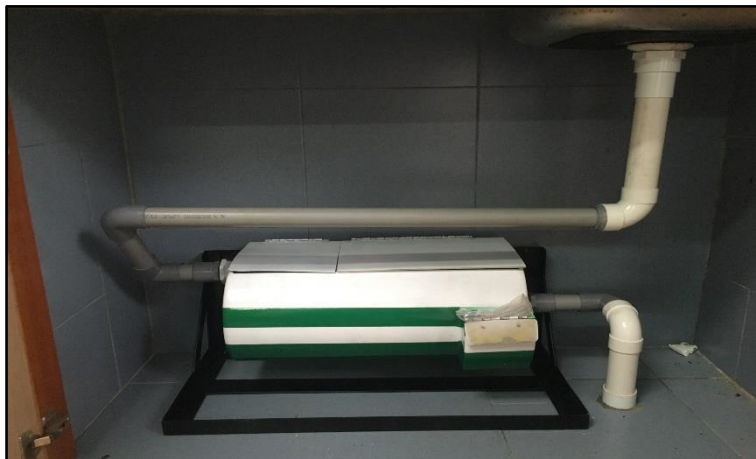
Rajah 19: Sambungan paip ke lubang keluar yang asal setelah proses mengambil sampel
