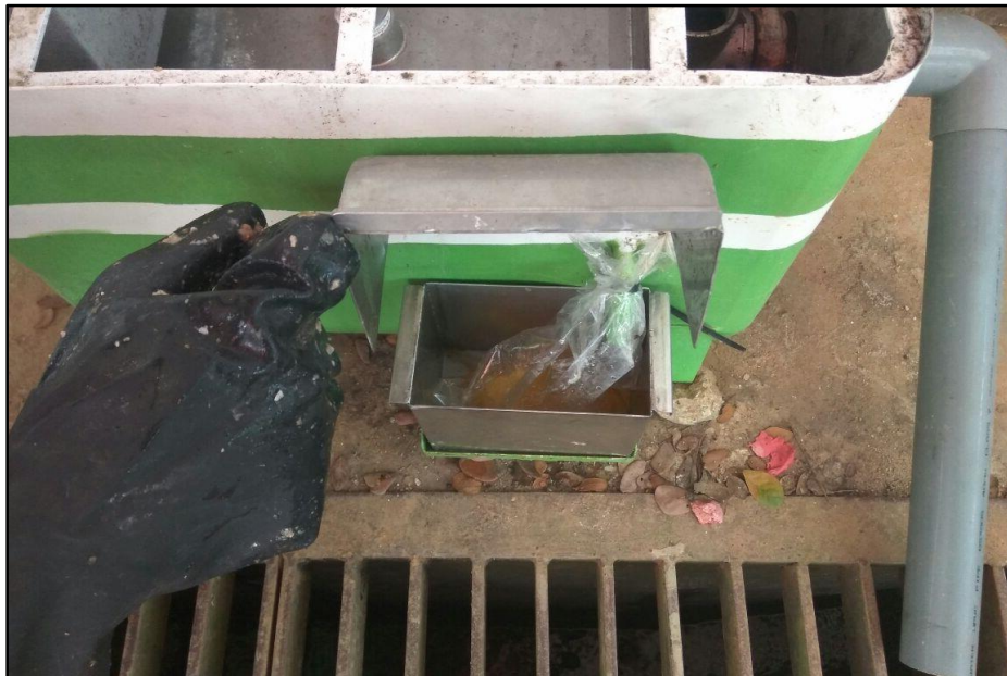
Rajah 61: Selepas beberapa lama, minyak yang terperangkap di dalam akan keluar daripada saluran minyak.
