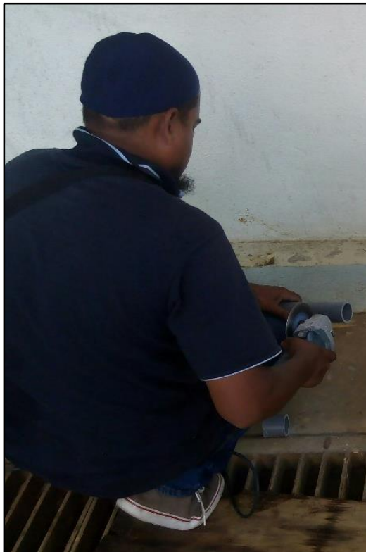
Rajah 43: Persediaan sebelum proses pemasangan dilakukan
