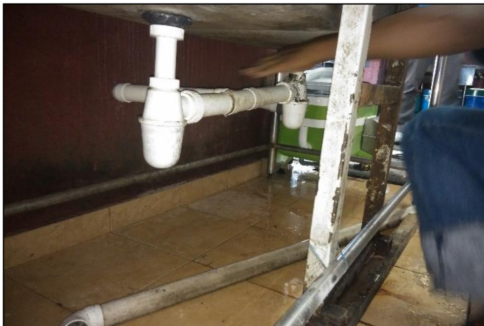
Rajah 51: Keadaan ketika proses pemasangan
