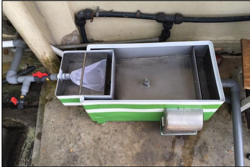
Rajah 38: Produk NoFAT tanpa penutup siap dipasang di bahagian dapur
