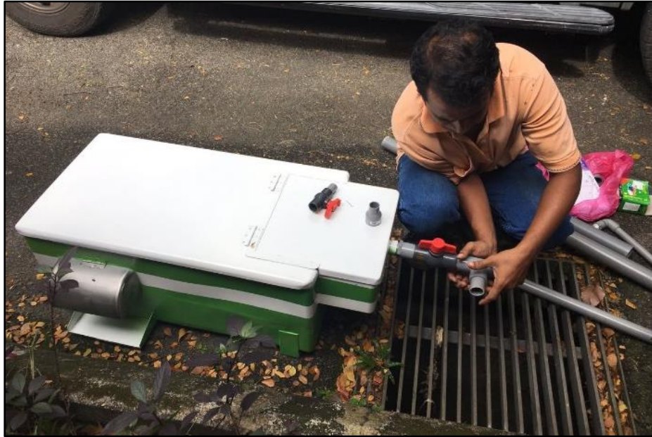
Rajah 52: Keadaan ketika proses pemasangan
