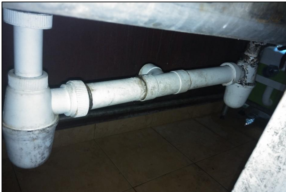
Rajah 49: Keadaan bawah sinki dapur sebelum pemasangan produk NoFAT
