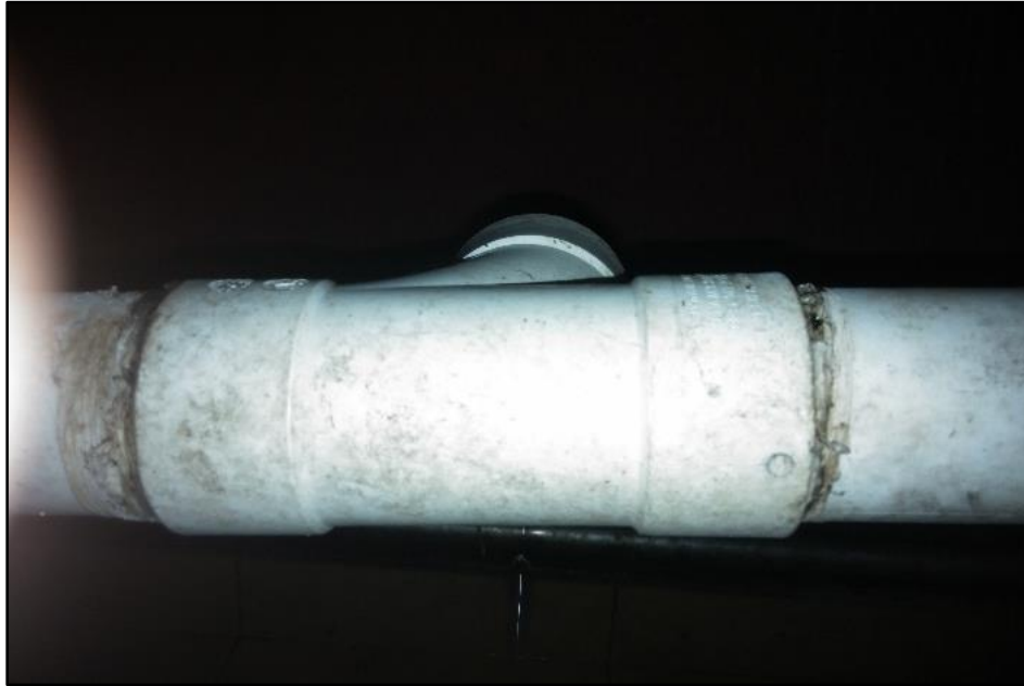
Rajah 50: Paip PVC yang digunakan sebelum pemasangan produk NoFAT
