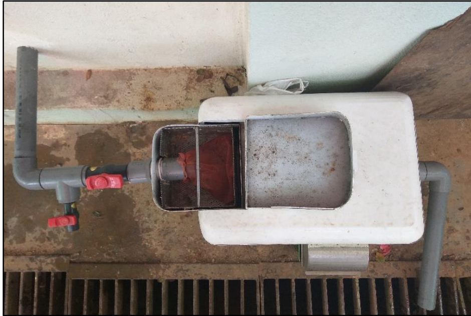
Rajah 60: Sisa makan terperangkap di dalam karung di bahagian air masuk.
