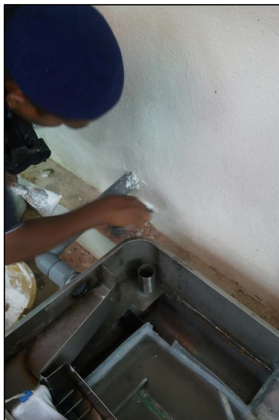
Rajah 45: Paip dari sinki disambung terus ke produk NoFAT
