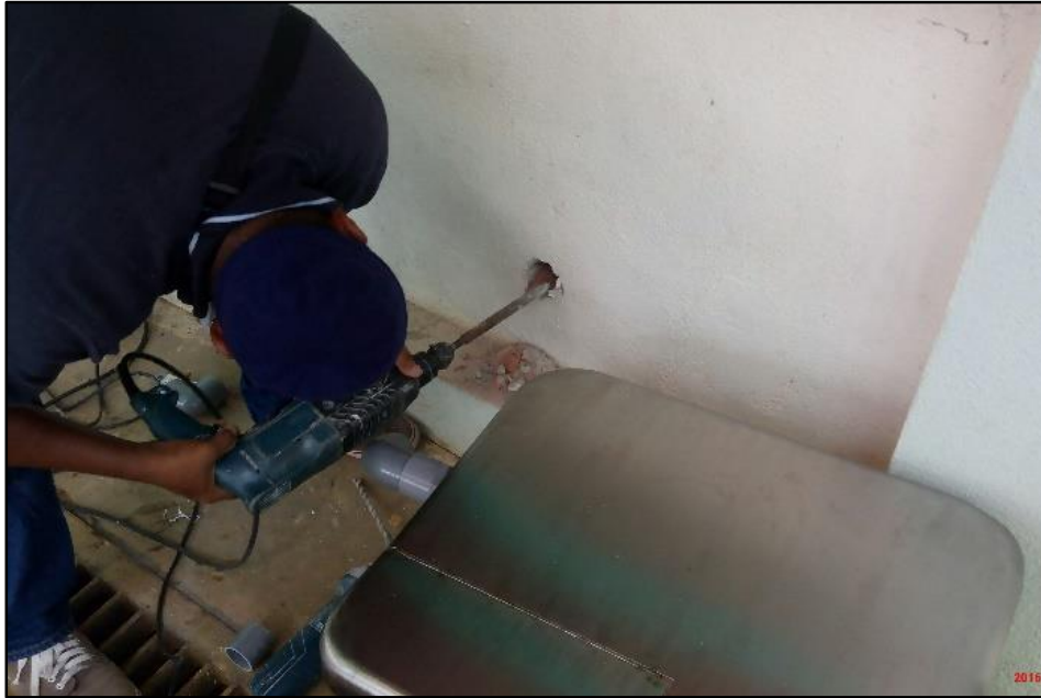
Rajah 44: Lubang ditebuk untuk laluan paip yang disambung ke produk NoFAT
