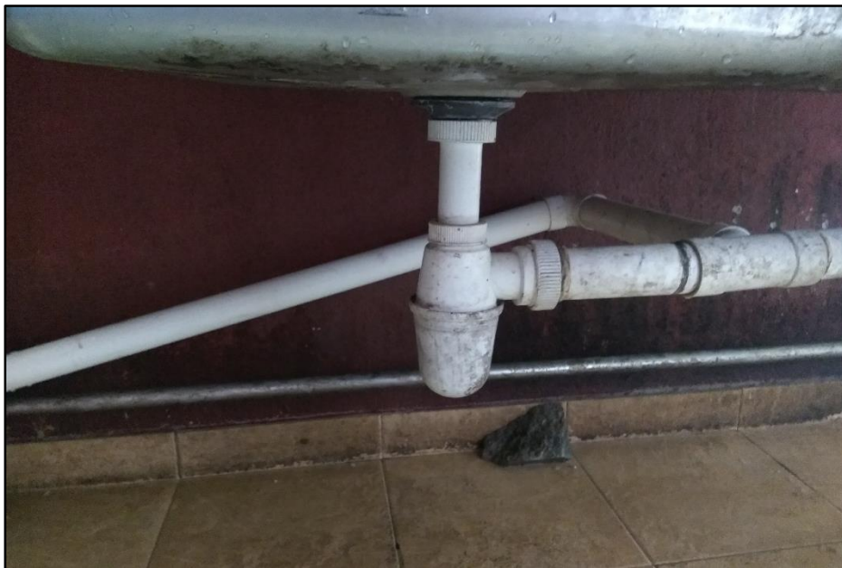
Rajah 57: Paip untuk saluran air ke produk NoFAT yang disambung dari sinki
