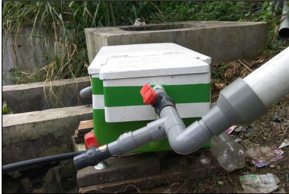
Rajah 56: Pemasangan paip dari sinki ke produk NOFAT di Medan Selera Ringlet, Cameron Highlands
