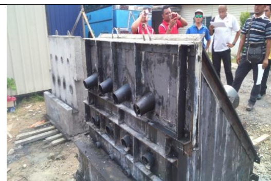
(d) Complete mainframe of mould structure is ready to use
